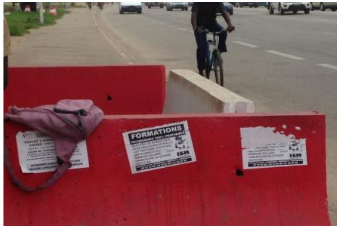
Figure X-21 : affichettes sur glissières de sécurité en béton à Port Bouët
