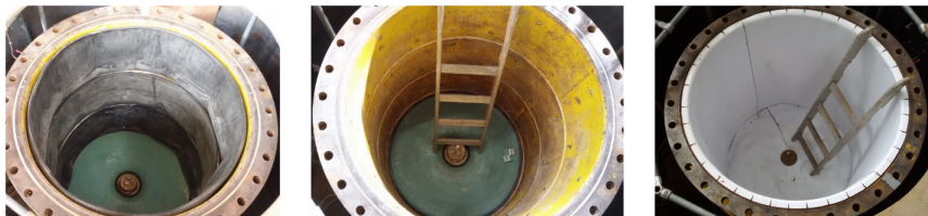
FIGURE 2.10 – Dépose des membranes latérales (gauche puis milieu) afin d’assurer des conditions limites de type BC3 et l’application de l’étanchéité.
