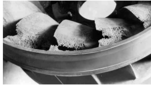
FIGURE 1.13 – Erosion de cavitation sur une turbine Francis. Source : [14]
