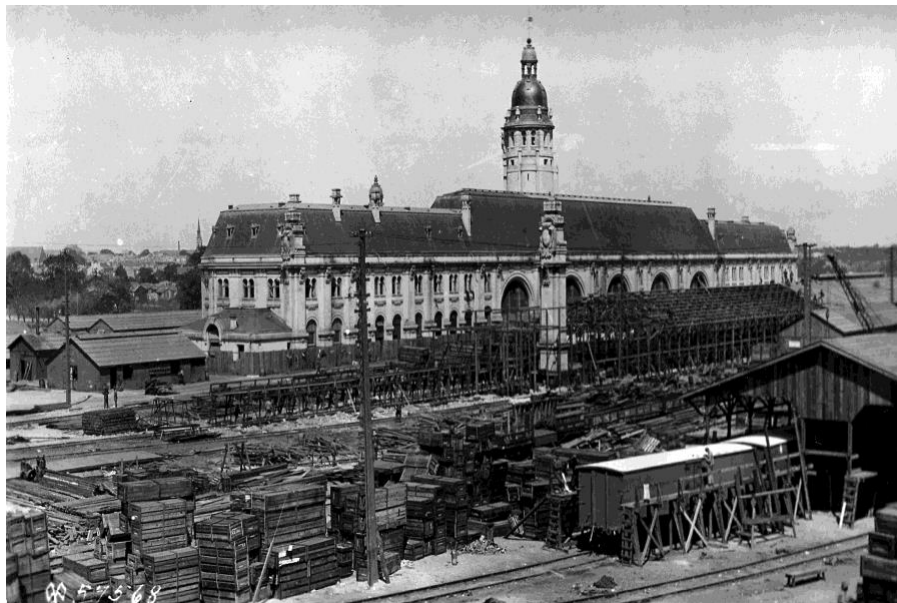
Illustration 3- Les ateliers de construction de matériel roulant du 35 e génie américain 424 .
