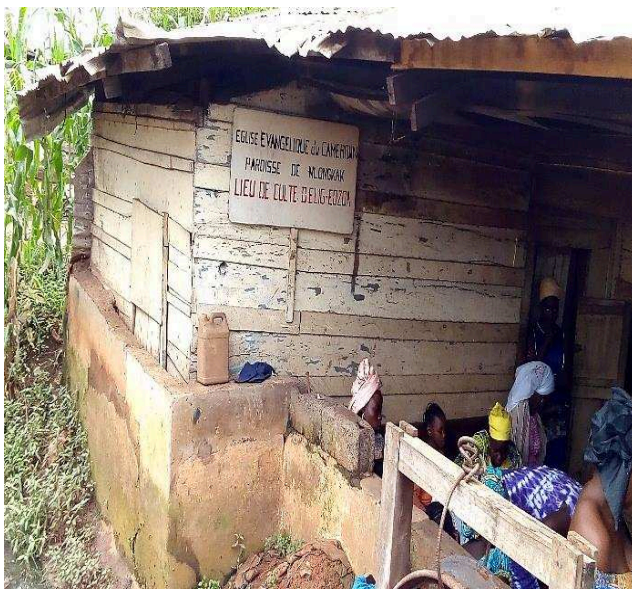
Photo 89 : Vue des assises d'une maison précédemment construite en planches de bois renforcées par des parpaings de ciment à Elig-Edzoa
