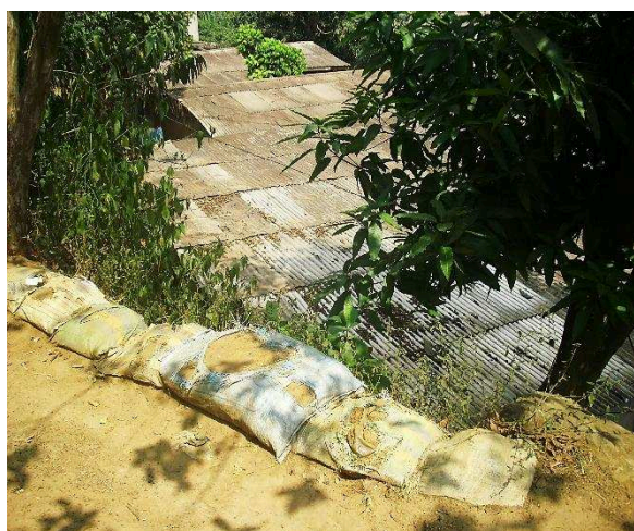
Photo 92 : Vue des sacs remplis de terre et empilés les uns sur les autres en amont des habitations à Etoa-Meki
