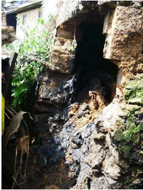
Photo 32 : Mouvement de masse ayant affecté les fondations d'une maison construite sur un flanc de colline escarpé à Nlongkak
