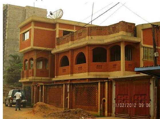
Exemple d'une structure en béton armé et remplissage en brique de terre compressée à Lomé (f)
