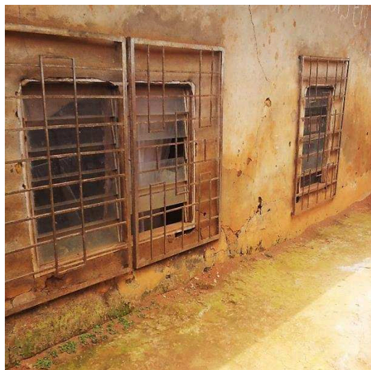
Photo 86 : Vue d'une maison dont les contours ont été remblayés plusieurs fois à Tongolo
