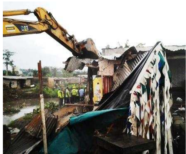
Photo 61 : Vue d'une scène de destruction des habitations anarchiques au quartier Tsinga-Élobie
