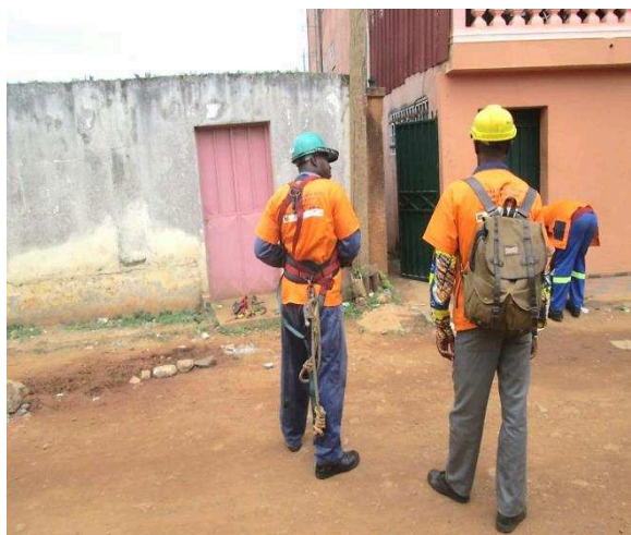
Photo 76 : Vue des agents chargés de la pose des lampadaires sur les sites non éclairés et du dépannage des lampadaires défectueux
