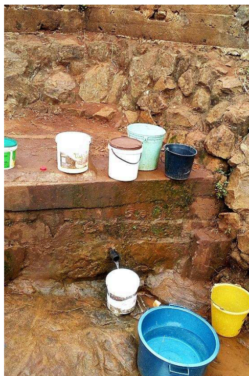
Photo 30 : Vue d'une source d'eau à Eba
