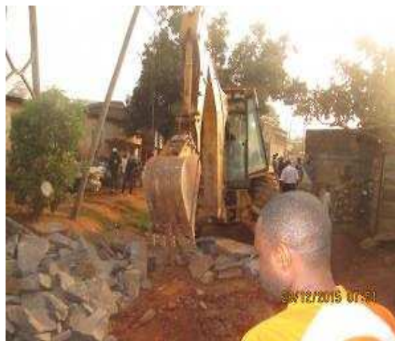
Photo 77 : Vue des travaux d'aménagement du ravin au lieudit "fin goudron" au quartier Melen 7B
