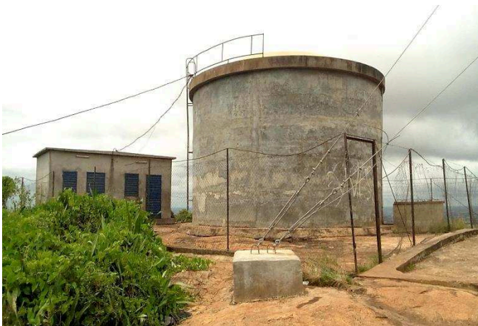
Photo 78 : Vue d'un château d'eau de 250 m 3 à Eba
