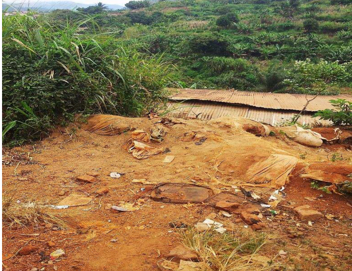
Photo 16 : Vue partielle de la toiture d'une maison habitation construite après un terrassement considérable à Oyom-Abang
