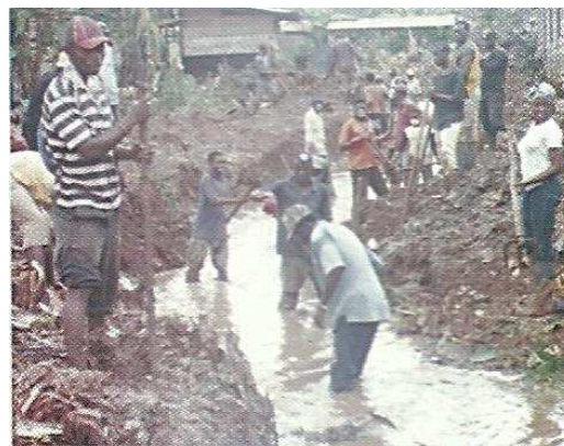
Photo 81 : Travaux de curage de la rivière Minlo'o
