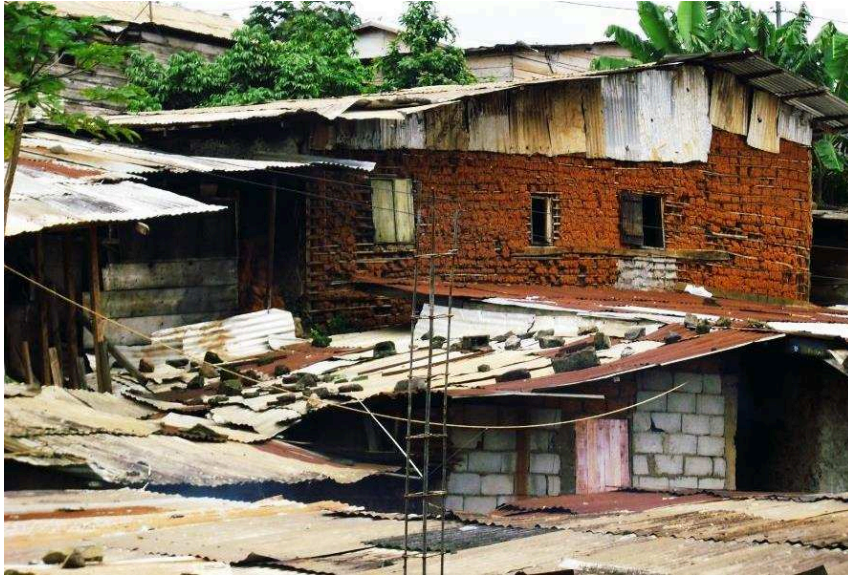
Photo 18 : Vue d'une série de maisons d'habitation construites après un terrassement considérable à Ngoa-Ekellé
