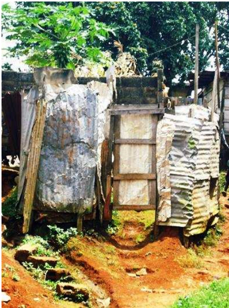
Photo 48 : Vue d'un lieu d'aisance précaire dont le sol est en terre
