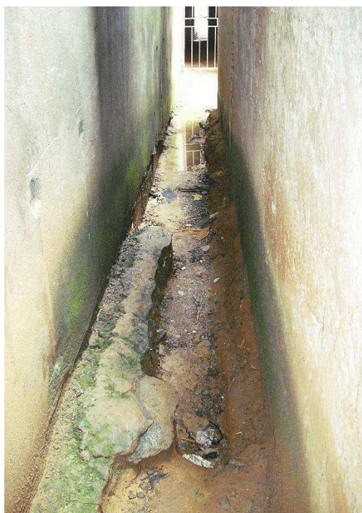
Photo 19 : Vue d'une ruelle de moins d'un mètre de large à Nlongkak © Djatcheu, mars 2015
