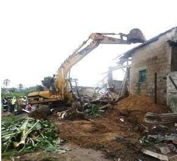
Photo 60 : Vue d'une scène de destruction des habitations anarchiques au quartier Mvog-Ada
