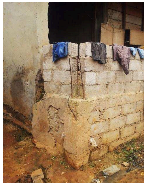
Photo 90 : Vue du "durcissement" des murs d'une maison par des parpaings de ciment à Elig-Edzoa
