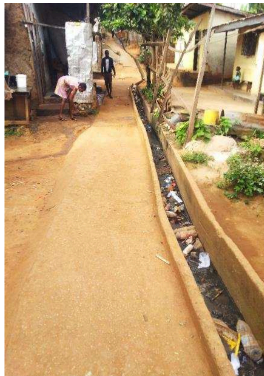
Photo 69 : Vue d'une voie aménagée avec du béton de ciment dans le quartier Melen
