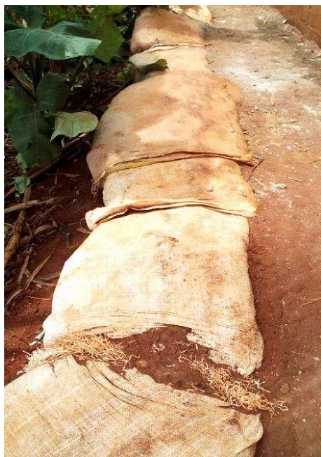
Photo 84 : Vue des sacs remplis de terre relevant d'une hauteur les berges d'une rigole à Melen
