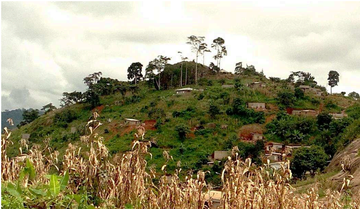
Photo 31 : Vue des maisons exposées à des risques de glissement de terrain à Eba
