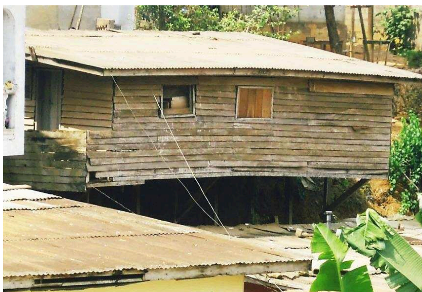
Photo 11 : Vue d'une maison d'habitation dont les murs et le sol sont construits en planches dans le quartier Etoa-Meki © Djatcheu, 2012
