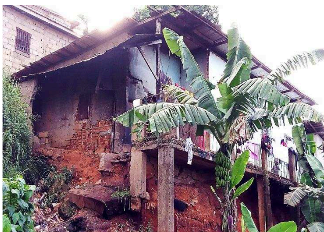
Photo 91 (a&b) : Vue d'une maison d'habitation maintenue en suspension par des poteaux construits en béton armé à Etoa-Meki
