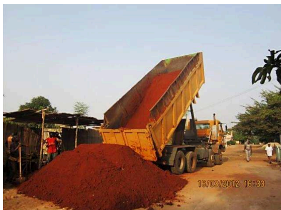
Étape 1 : Livraison de la terre dans le chantier (a)
