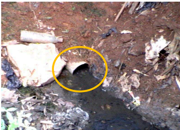
Photo 50 : Vue d'un "canon" camouflé d'évacuation des excréta vers une rivière à Nlongkak © Djatcheu, mars 2015
