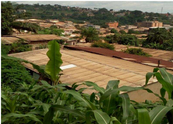
Photo 17 : Vue d'une série de maisons d'habitation construites après un terrassement considérable à Ngoa-Ekellé
