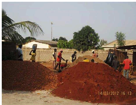
Étape 2 : Matériaux de construction en vrac (b)
