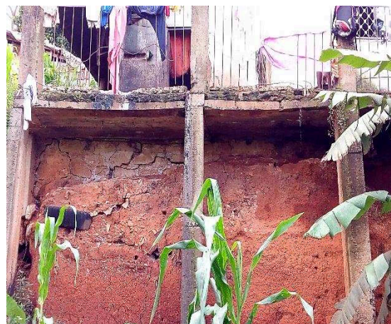
Photo 91 (a&b) : Vue d'une maison d'habitation maintenue en suspension par des poteaux construits en béton armé à Etoa-Meki
