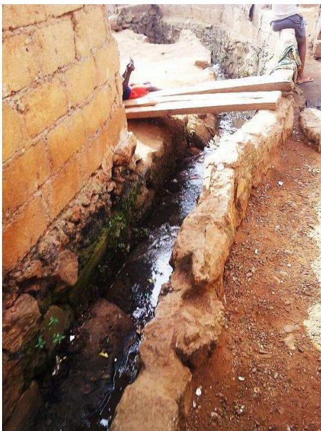
Photo 52 : Vue eau stagnante à proximité d'une maison d'habitation à Melen © Djatcheu, mai 2015
