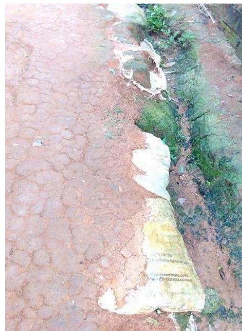
Photo 85 : Vue des sacs remplis de terre relevant d'une hauteur les berges d'une rigole à Mfandena
