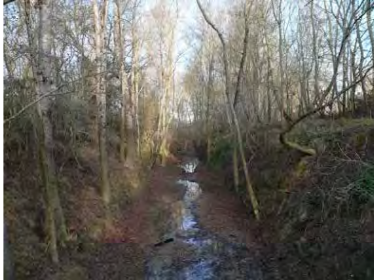
Figure 27 : Levées de terres destinées à drainer les crues dans la plaine de la Save en amont de l'Isle-Jourdain (Auradé)
