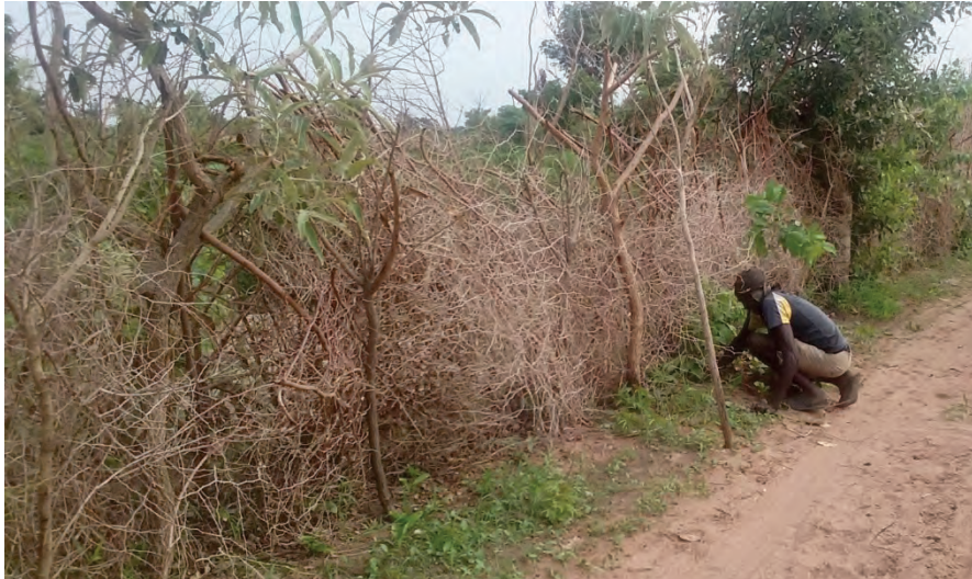
Photo 21: travaux d'entretien sur une clôture
