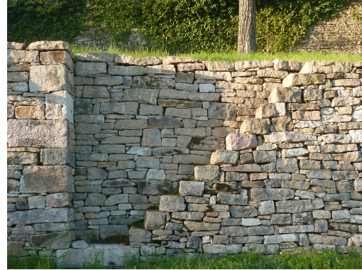
(b) Mur de soutènement de talus avec escalier intégré (France) : ©N. Savalle
