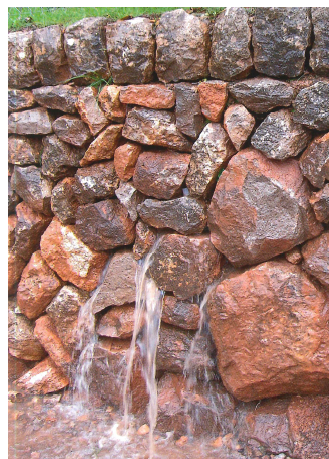
FIGURE 1.9 – Vue d'un écoulement d'eau traversant un MSPS : ©F-X. Emery COSTE et collab. [2008].
