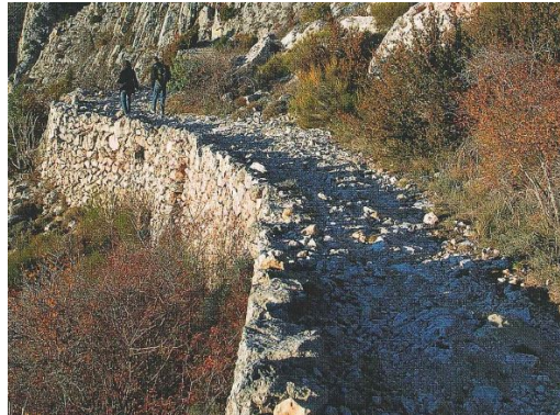
(d) Mur de soutènement d'un chemin de montagne (France) : ©F-X Émery [COSTE et collab., 2008]
