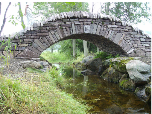
(e) Pont avec voûte clavée (Canada) [DSWAC]
