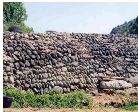
(f) Perré de digue de la rivière Beaulieu (France) [ROUVIÈRE, 2012]
