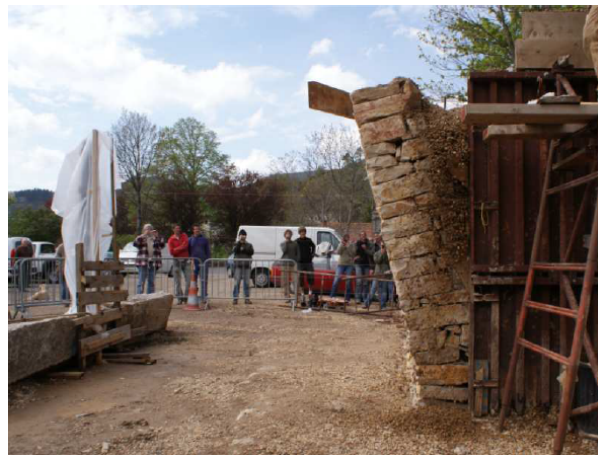
FIGURE 1.14 – Photographie de la rupture en renversement d'un MSPS testé par COLAS [2009].
