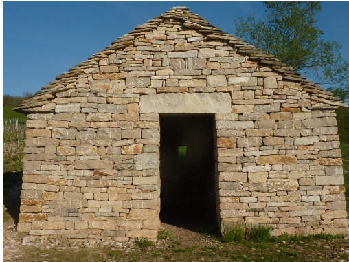
(c) Cabane de vigneron rénovée (France) : ©N. Savalle
