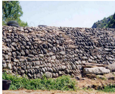
(f) Perré de digue de la rivière Beauce (France) [ROUVIÈRE, 2012]
