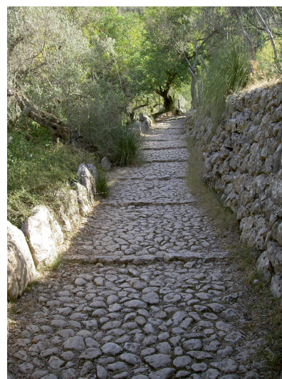
(b) Serra de Tramuntana à Majorque : chemin de randonnée (calade en pierre sèche) bordé de nombreuses structures en pierre sèche [TCAT].
