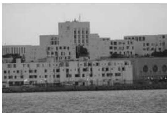
Figure 65 Le complexe de Sidi Fredj
