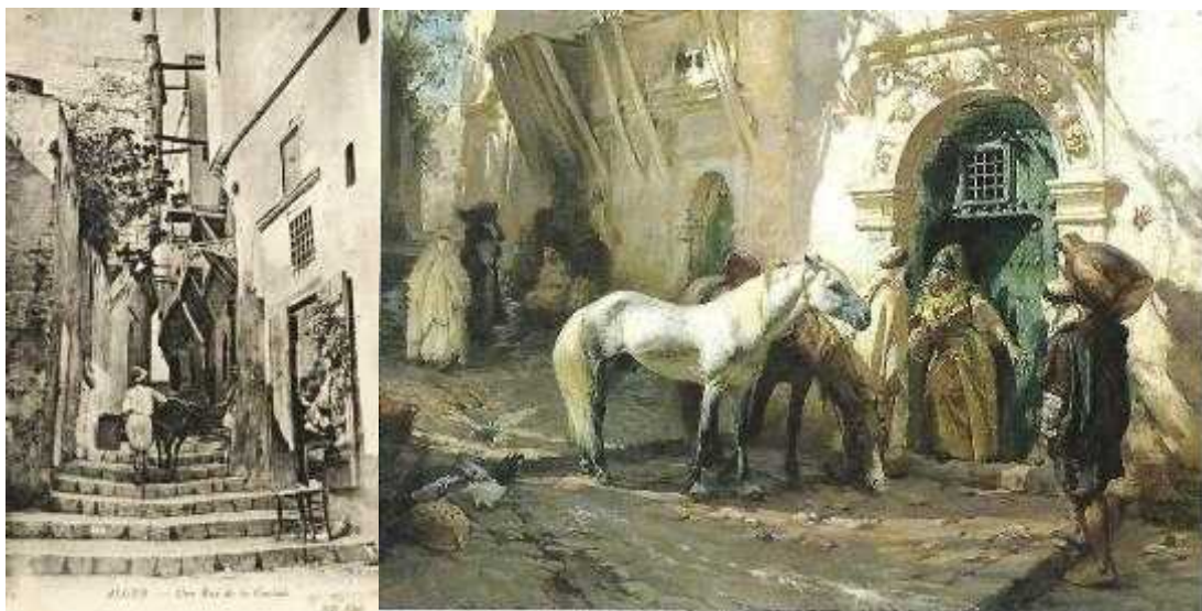
Figure 15 Le transport des ordures dans une rue à la Casbah
