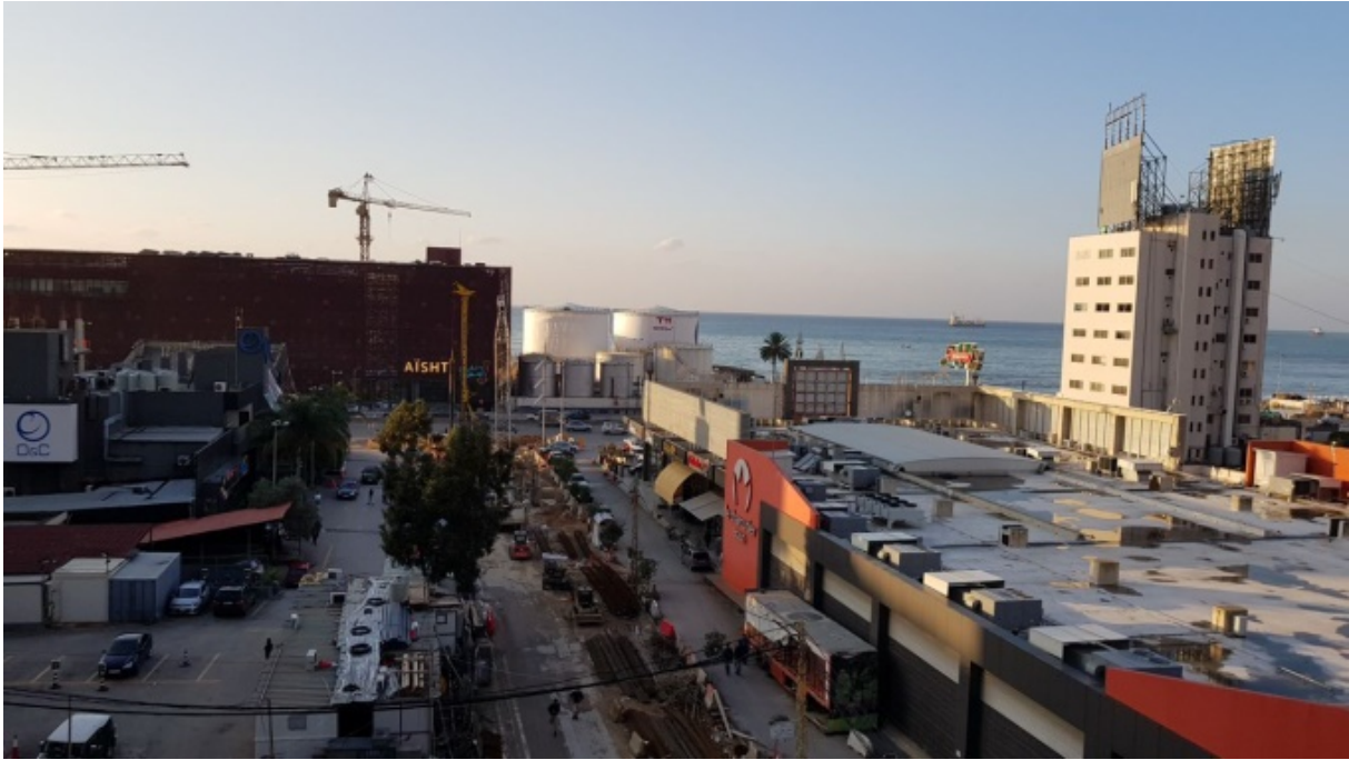
Figure 3-10 Réservoirs du gaz bien vu de Antelias
