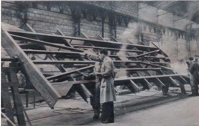
Soudage du châssis sur positionneur tournant. Pour l'ensemble du wagon on utilise 3 000 électrodes.
