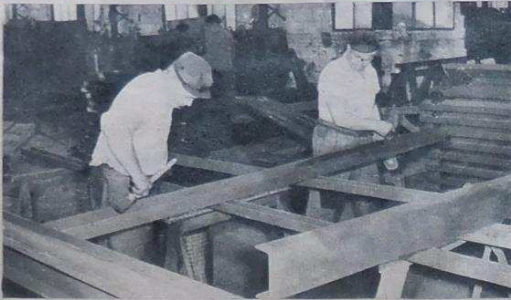
Immédiatement après les 3 passages à la grenailleuse, on procède à « l'impression », c'est-à-dire à l'application obligatoire au pinceau d'une peinture ARI (minium de fer).
