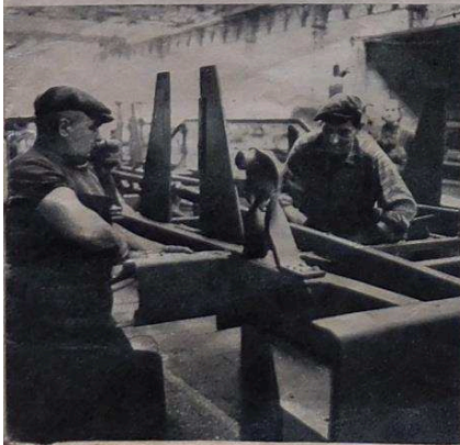
Rivetage des supports de suspension, 270 rivets sont utilisés pour l'ensemble du wagon.
