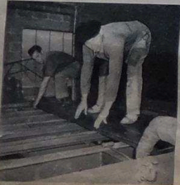
Mise en place du plancher.
