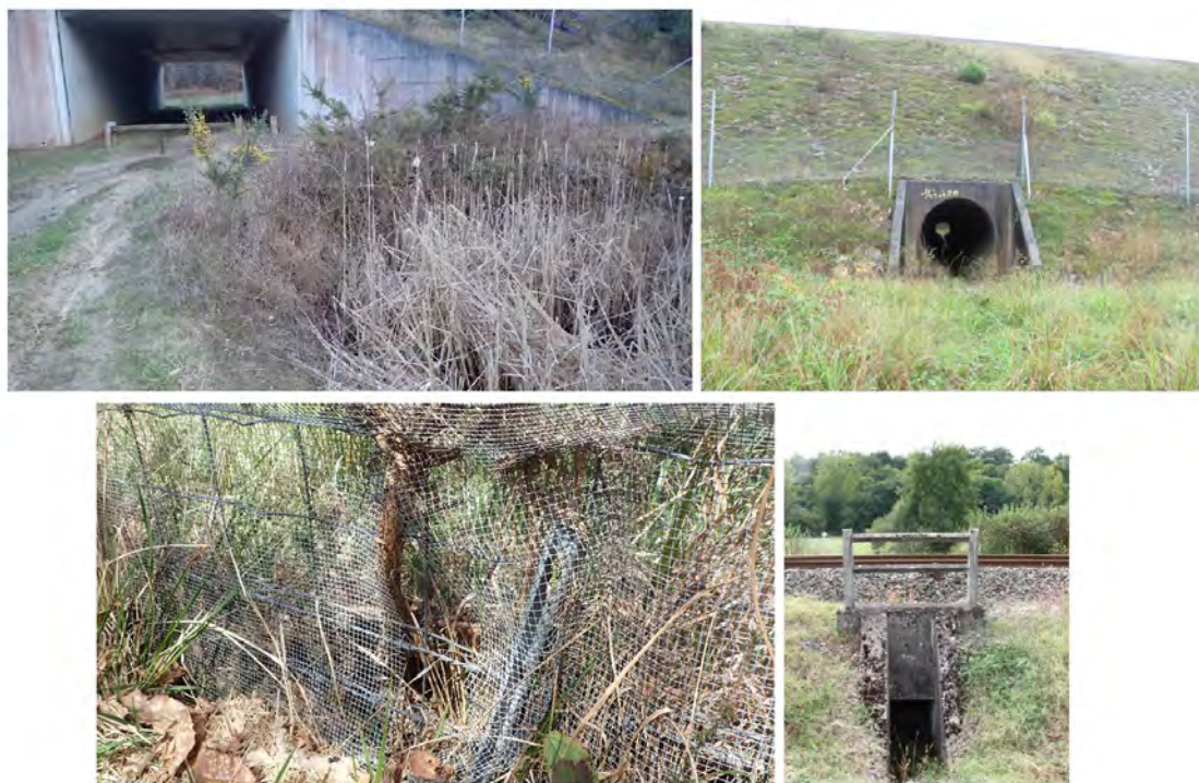
FIGURE H – Passages souterrains sous l’A89 et la voie ferrée (buses et passage agricole) ainsi que grillage à petite faune de l’A89 perforé
