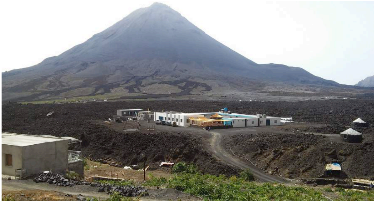
Figure 8.3. Au premier plan à gauche, une maison construite sur les flancs du Monte Amarelo ; au second plan au centre, l'imposante pension Casa Marisa ; au troisième plan, à droite du Pico de Fogo, le cratère de l'éruption de 2014-2015 (Pedro Danilo Fontes, juillet 2016).
