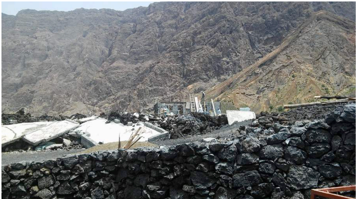
Figure 8.4. Au premier plan, la route réalisée par les sinistrés après l'éruption de 2014-2015, au second plan, le toit en ciment d'une maison détruite par la lave et au troisième plan, une maison en train d'être construite (Pedro Danilo Fontes, juillet 2016).
