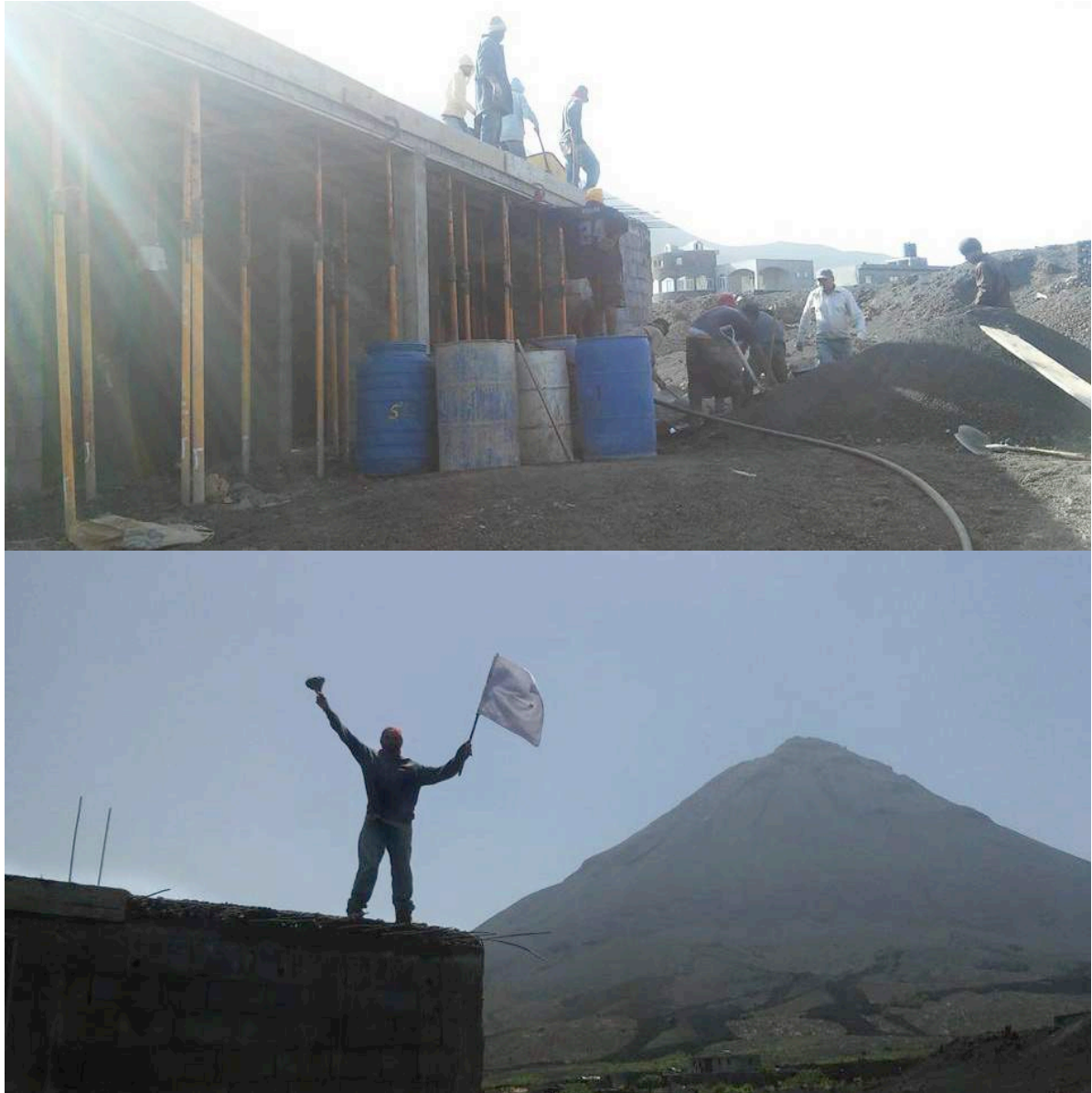
Figure 8.9. Sur la première photo, des proches aident un habitant du village à couler le toit en béton de sa maison (avril 2017, Pedro Danilo Fontes). Sur la deuxième photo, l'un d'eux se tient sur le toit de la maison fraîchement achevée, brandissant un drapeau en signe de victoire (avril 2017, Pedro Danilo Fontes).
