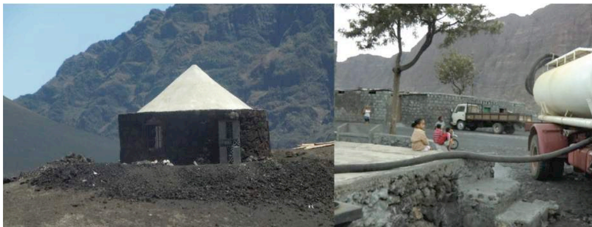
Figure 1.22. Récupération de l'eau de pluie avec les toits des maisons et approvisionnement par camion-citerne (Chourraqui, 2011).
