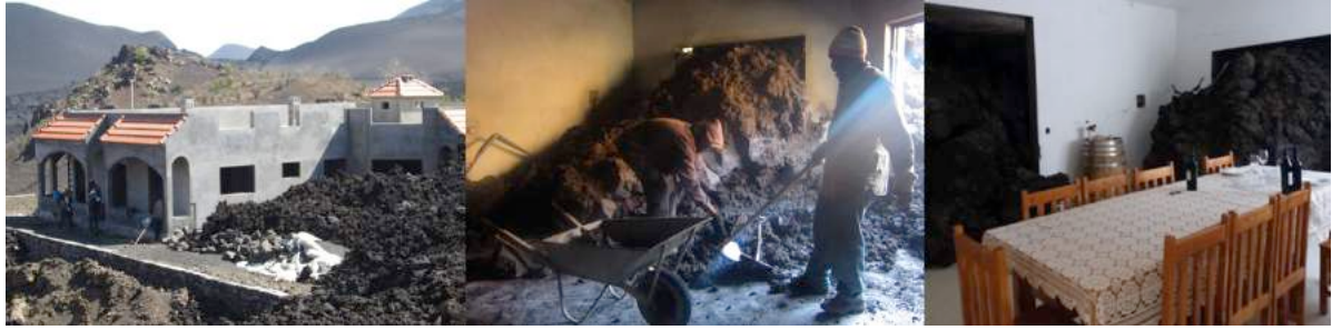
Figure 8.14. Les deux photos à gauche montrent l'édifice construit par David Montrond, en train d'être remis en état (Chouraquí, janvier 2015) ; sur l'image à droite, on voit que les travaux sont achevés; Teresa Nunes, avril 2017).
