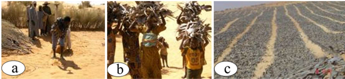
Fig. 1.20 : Fixation mécanique des dunes par épandage des rachis des palmiers doum. (a) mise en place du clayonnage, (b) transport des rachis des doumiers et (c) épandage des rachis de doumiers (PASAM, 2007).
