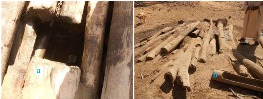
Fig. 1.41 : (a) Stipes de palmiers dattiers servant pour le cuvelage des puisards et (b) d'abreuvoir des animaux au Manga.
