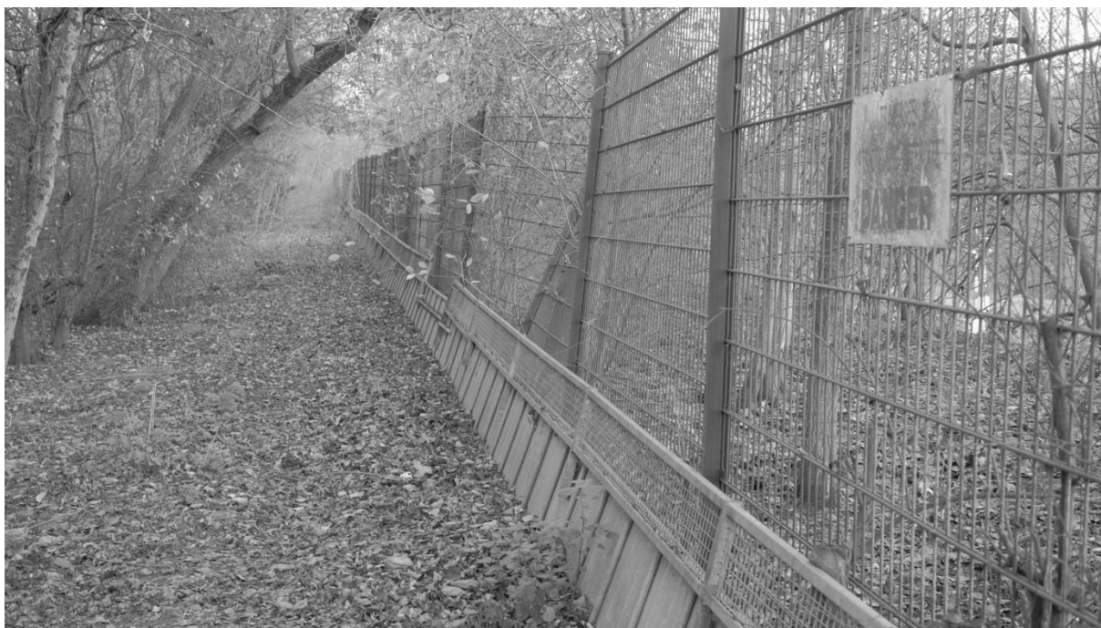
Figure 17 : Dispositif de cloisonnement des voies de chemin de fer à l'aide de palplanches, Parc du Sausset , © Léo.Martin.
