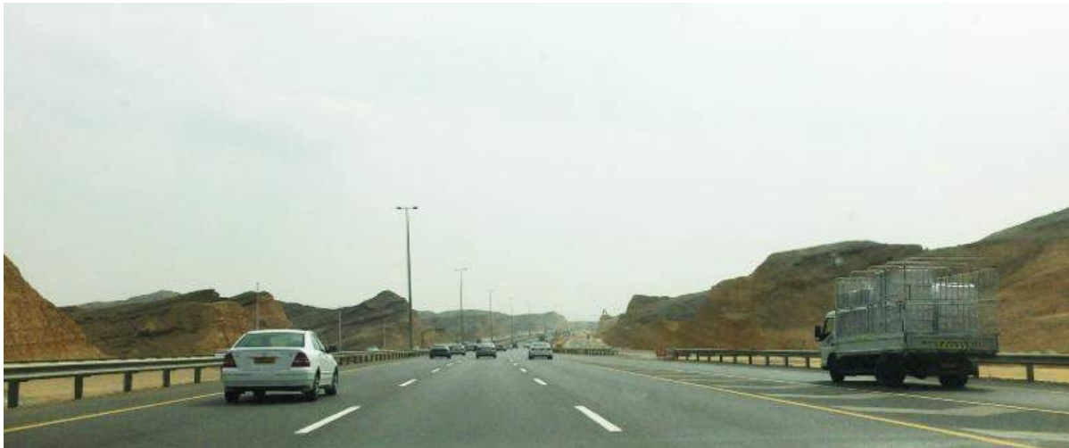
Figure 4 Muscat Expressway depuis al-Khoud en direction du centre
