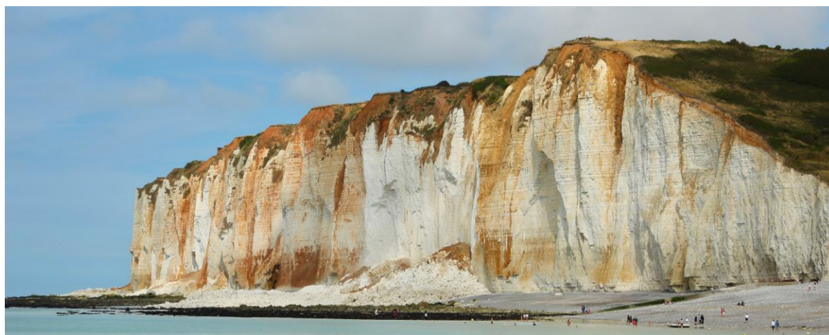
Figure 1.24 – Effondrement d'un pan entier de la falaise des Petites-Dalles (25/08/16). La surface la plus blanche correspond à la cicatrice de l'effondrement.
