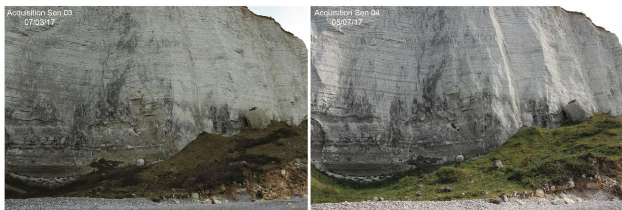
Figure 2.22 – Photos illustrant la végétation qui recouvre le dessus du talus d'éboulis. A noter la densification de la végétation sur la photo de droite lors de l'acquisition de Senneville-04 (05/07/17) par rapport à Senneville 03 (07/03/17).
