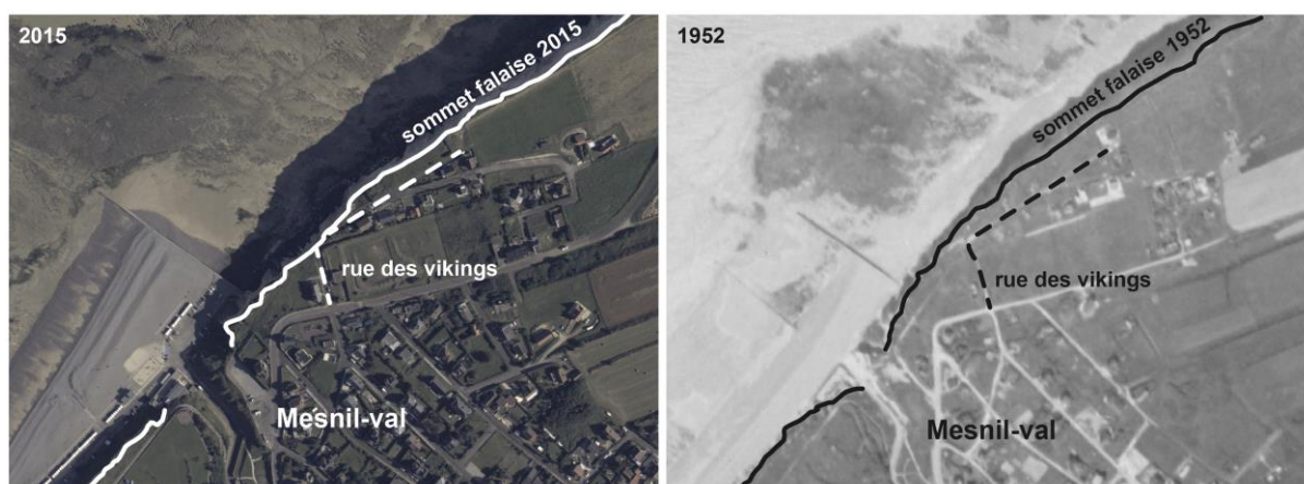
Figure 1.23 – Photos aérienne du sommet de la falaise de Mesnil-Val illustrant le recul de falaise entre 1952 et 2015 © IGN.
