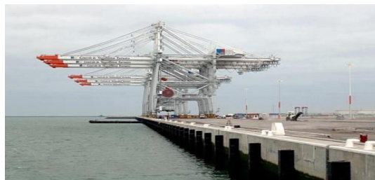
Figure I-10. Grues de quai
