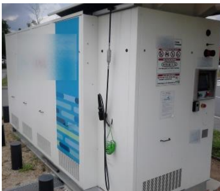
Figure 12. Photographie d'une station de production (électrolyseur) et de distribution d'hydrogène à Lyon (source : Nicolas Dupuis).
