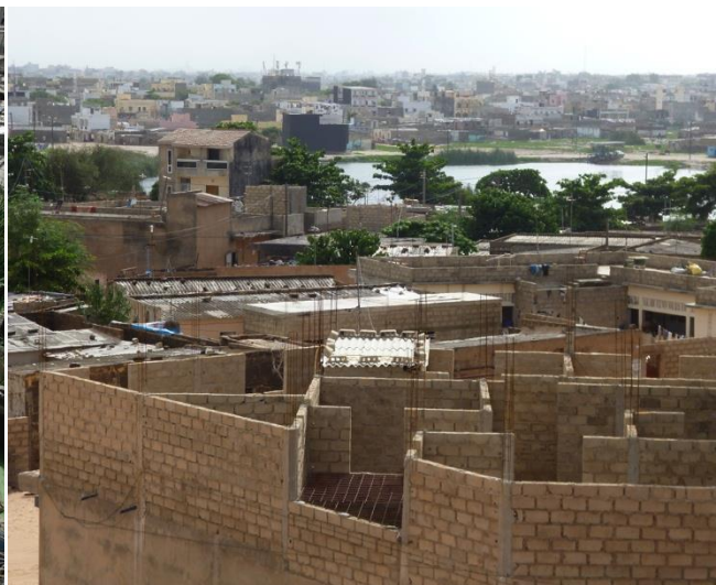
Photo 2 : quartier spontané d'Aïnoumady 4 de Yeumbeul-nord en février 2011 (Cliché P. Diatta)
