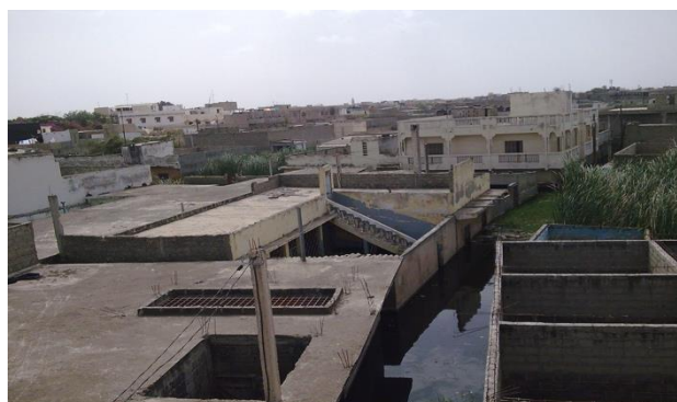
Photo 4 : Quartier inondé de Darou Salam 1 Commune d'arrondissement de Yeumbeul-nord en août 2012 (Cliché : P. Diatta)
