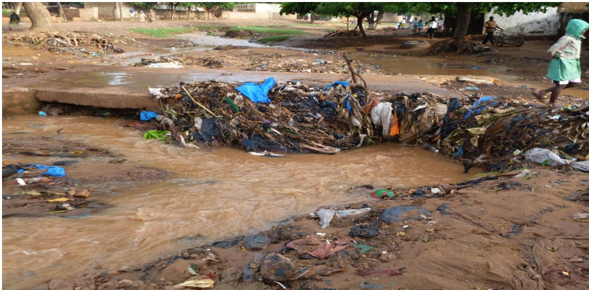
photo 39 : Caniveau bouché à Nafadji en Commune I à Bamako en juillet 2012 (Cliché : P. Diatta)
