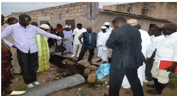
Photo 5 : Visite de terrain d'une délégation du ministère de l'hydraulique et de l'assainissement public à Yeumbeul-nord le 22 août 2012 (Cliché : P.Diatta)
