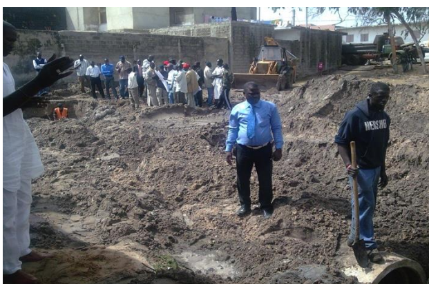
Photo 7 : Pose de tuyaux de drainage des eaux de pluies au quartier Léona Commune Yeumbeul-nord en février 2011 (Cliché : P. Diatta)
