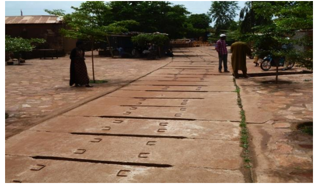
Photo 17 : La couverture du collecteur de Sikoro en août 2012 (Cliché : P. Diatta)
