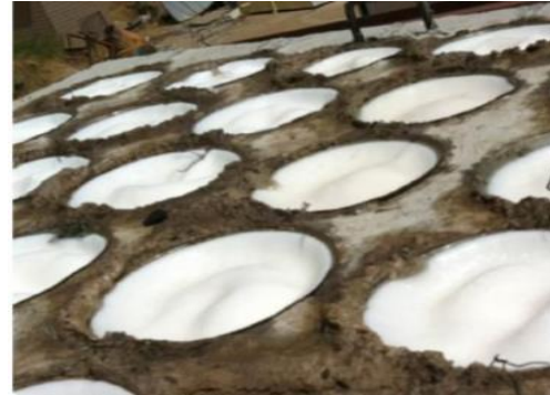
Plancher en béton avec MCP
