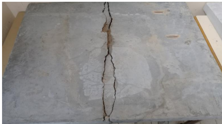
suivi d'une ruine par écrasement de la matrice en face comprimée
