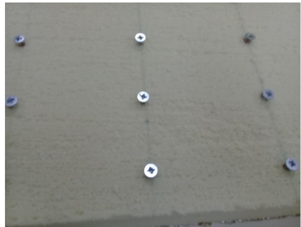
2-Placement des connecteurs
