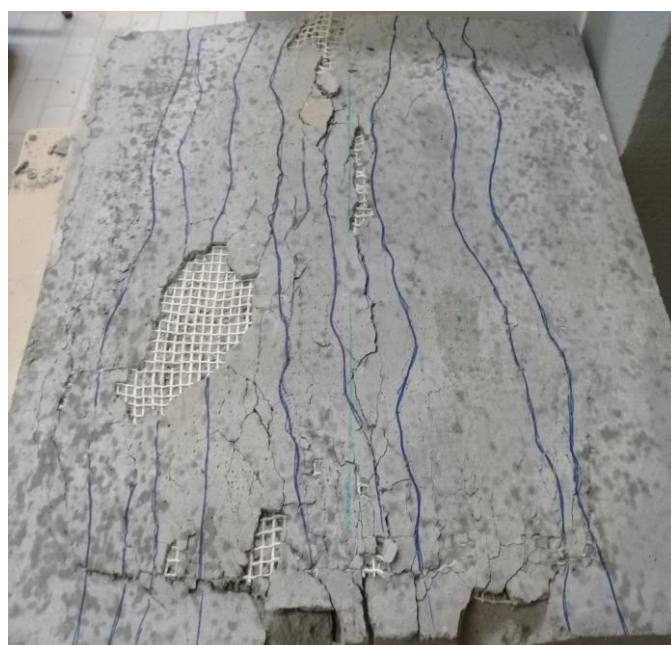
Dalle 10% MCP-TRC chauffée à 40°C
