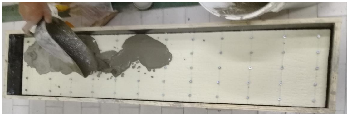
3-Coulage du parement
