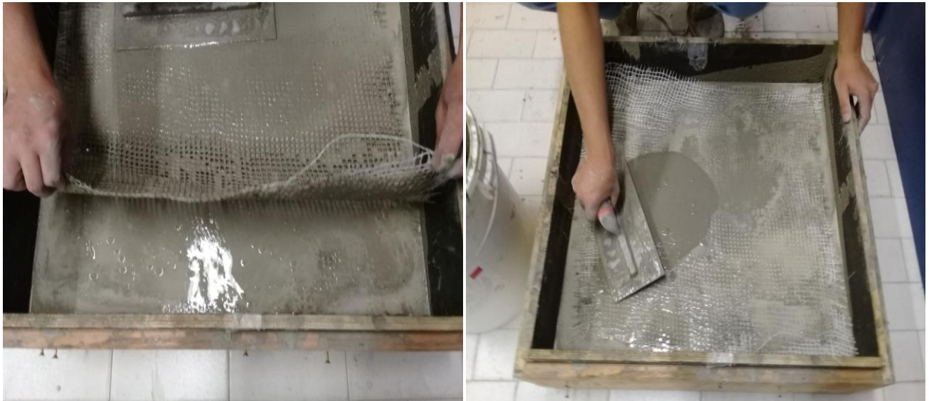
Figure IV-1 Moulage au contact des dalles légères en MCP-TRC
