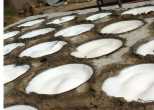
Plancher en béton avec MCP
