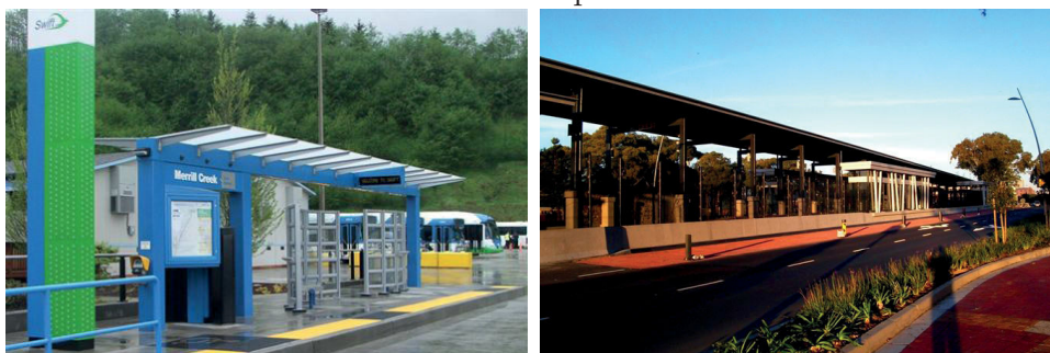
A gauche, station ouverte à Everett (source : metro magazine) ; à droite , station ouverte à Cape Town.
