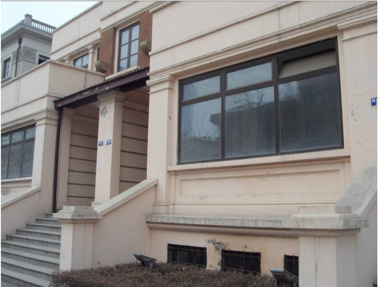
Figure 87 : Concession italienne, restauration en cours
