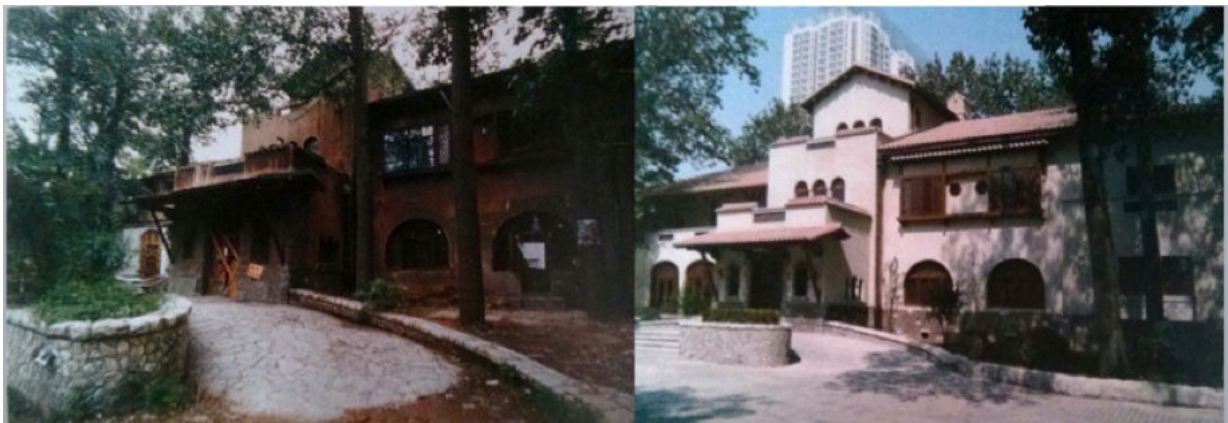
Figure 84 : Résidence Puyi avant et après les rénovations
