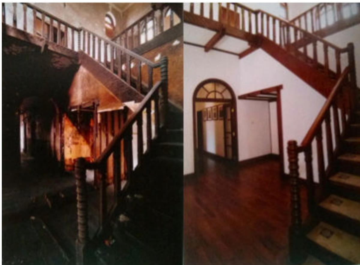
Figure 85 : Restauration de l'escalier de la résidence
