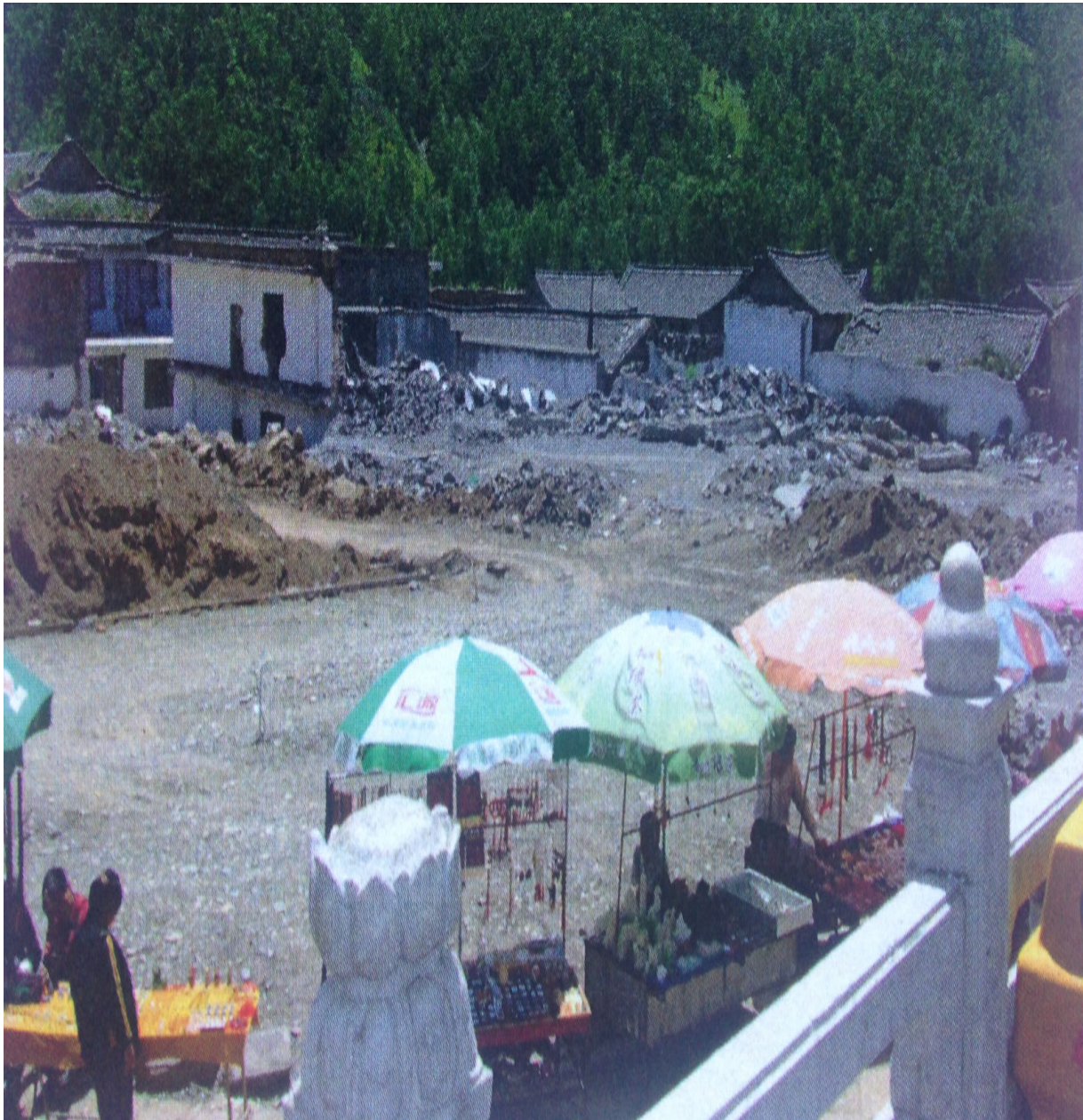
Figure 16 : Démolition des résidences à Taihuai
