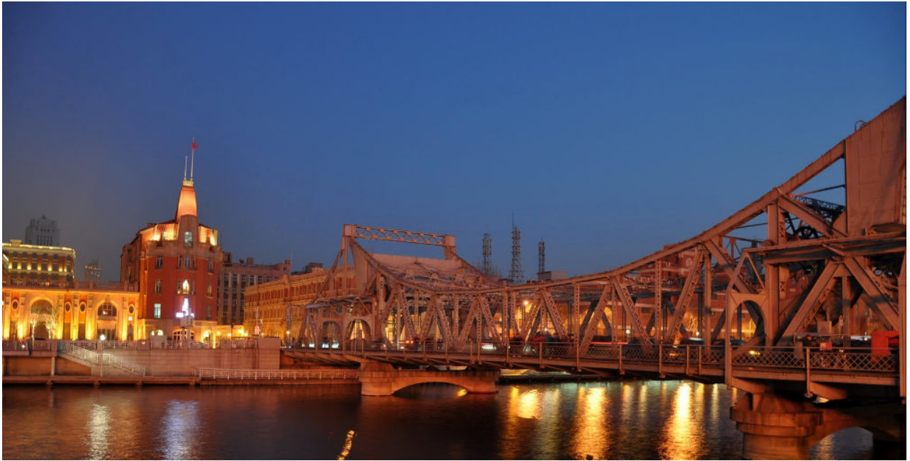
Figure 100 : Pont Jiefang, vue de nuit du Jinwan Plaza.
