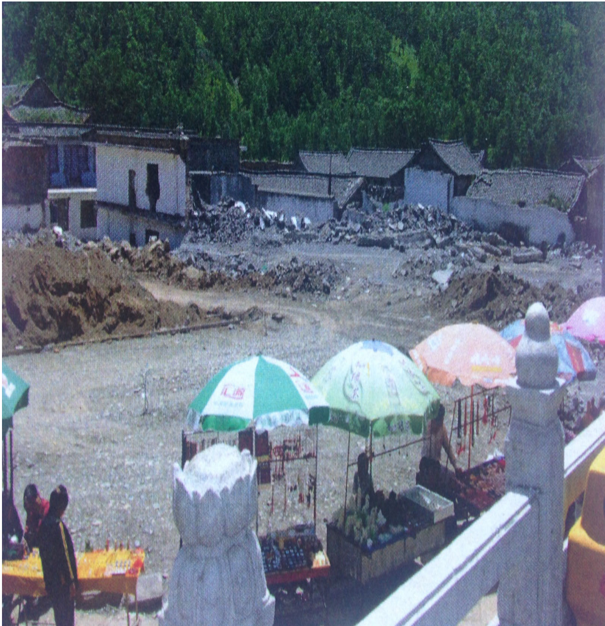
Figure 16 : Démolition des résidences à Taihuai
