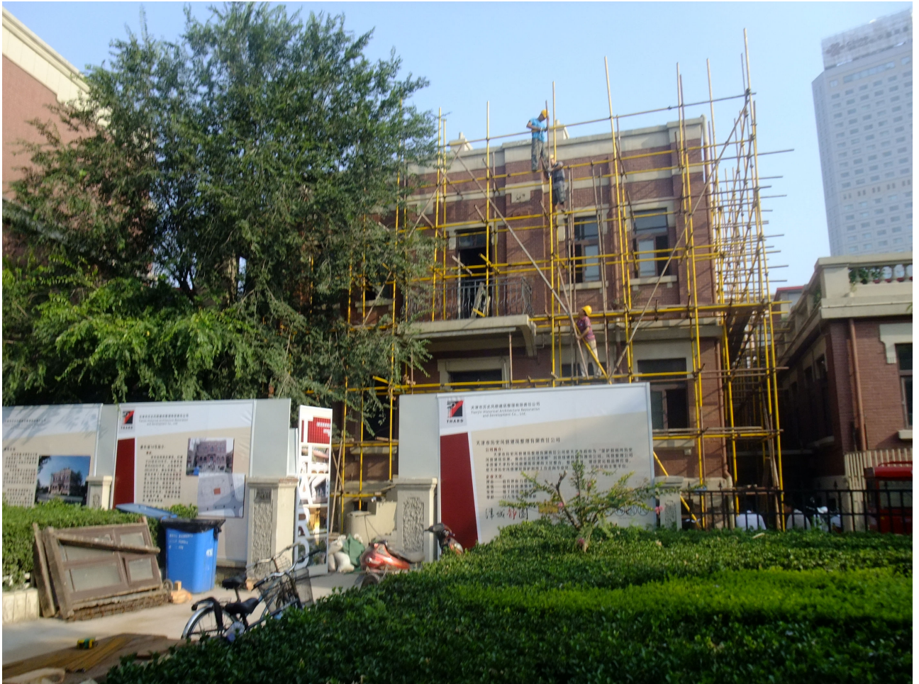
Figure 89 : Travaux de restauration de la concession anglaise
