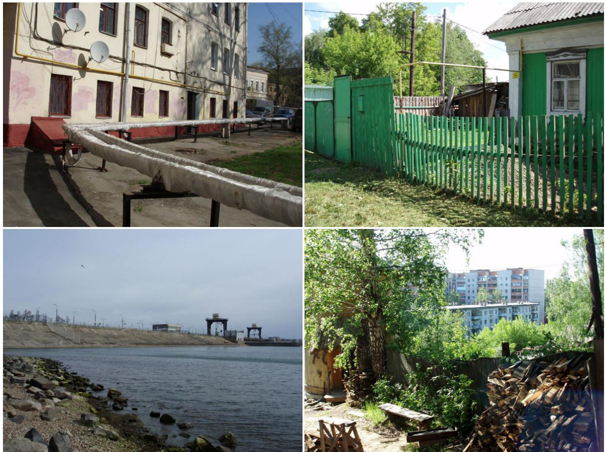
Photographie 9 : Raccordement au gaz naturel, hydroélectricité et chauffage au bois
