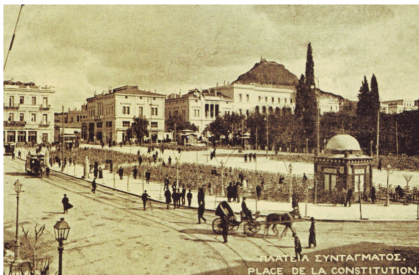
Image 16 : La place Syntagma en 1900 avec des terrasses de cafés et des restaurants sur son parvis central, les lignes du tram et les premiers kiosques d'information. Au fond, la colline du Lycabette (Source : carte postale tirée de l'ouvrage ΝΑΘΕΝΑΣ, Γ., ΚΟΥΡΜΠΕΛΗΣ, Α., ΒΛΑΣΤΟΣ, Θ., et al. (επιμ.), Από τα παμφορέια στο μετρό. 170 χρόνια δημόσιες συγκοινωνίες Αθηνών - Πειραιώς - Περχώρων , Αθήνα : Μύλητος, 2007)
