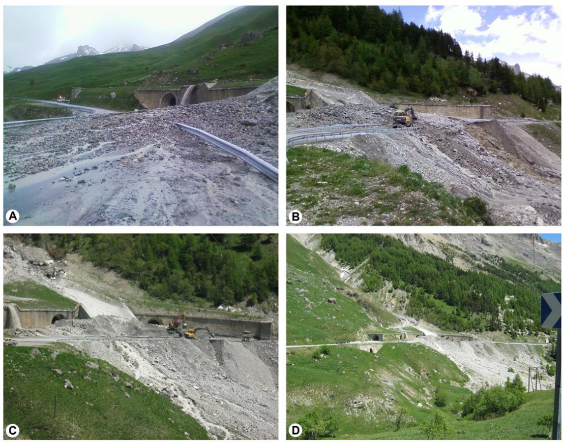
Figure 25. Catalogue photographique de l'évènement du 4 juin 2012 sur le torrent du Rif Blanc (source : CG05), A. Vue latérale de la première crue depuis la route D1091 sur l'apex sens Briançon - Col du Lautaret, B et C vues générale depuis la D1091 sens Col du Lautaret après le passage de la seconde crue
