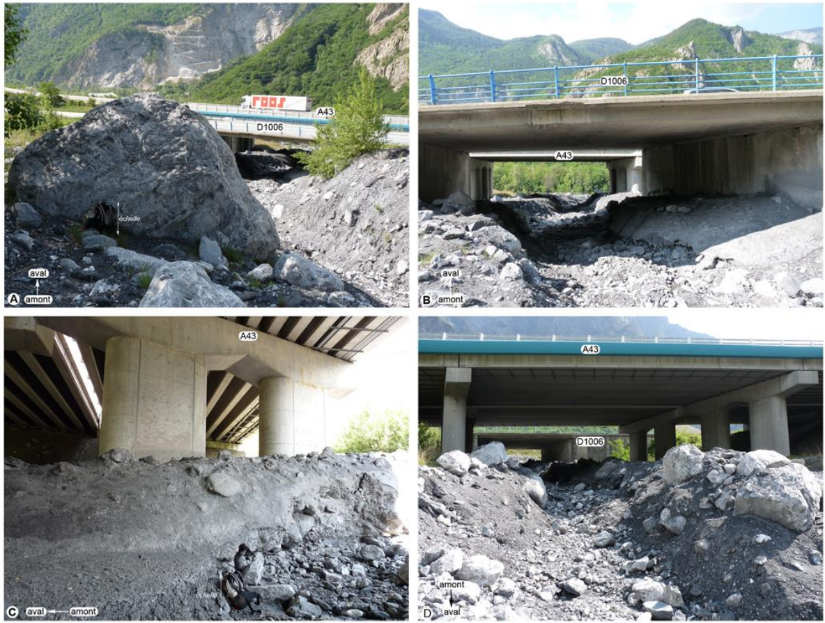
Figure 29. A. Bloc rocheux déposé par la lave torrentielle de 2007 à environ 50 mètres en amont des ponts routiers de la D1006 et de l'A43 sur le torrent du Rieu Sec, B. Vue amont du chenal principal du Rieu Sec à l'entrée du pont de la D1006 (On note la dégradation du pont par les coulées au niveau du tablier inférieur du pont) C. Vue latérale droite du lit torrentiel du Rieu Sec sous le point de l'A43, D. Vue aval du lit torrentiel du Rieu Sec en direction des points de l'A43 et de la D1006
