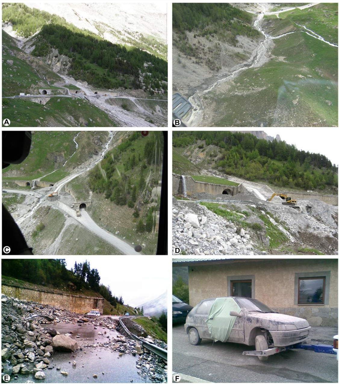
Figure 24. Catalogue photographique des évènements torrentiels de 2008 sur le Rif Blanc (source : CG05) A. Vue générale de l'apex et des dégâts sur la route D1091 depuis le col du Lautaret, B. Vue plongeante en amont du torrent depuis un hélicoptère, C. Vue latérale de l'apex et des dégâts sur la route D1091 depuis un hélicoptère, D. Vue en contrepied de l'apex et dégâts sur la route D1091, E. Vue des dommages depuis la route D1091 sur l'apex sens Col du Lautaret – Briançon, F. Remorquage du véhicule emporté
