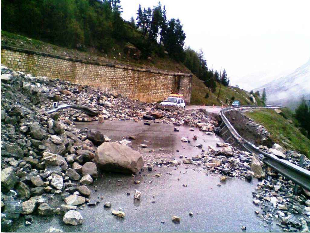
La route départementale D1091 en mai 2008 lors d'un évènement torrentiel sur le Rif Blanc (Hautes-Alpes, France)
