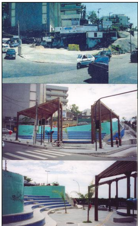
Photographie 16 : Construction de la place de Vidigal
