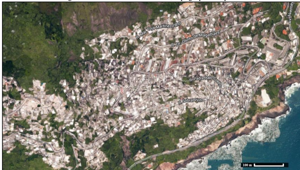
Vue aérienne de Vidigal, Zone Sud de Rio de Janeiro, topographie de pente modérée/accrue
