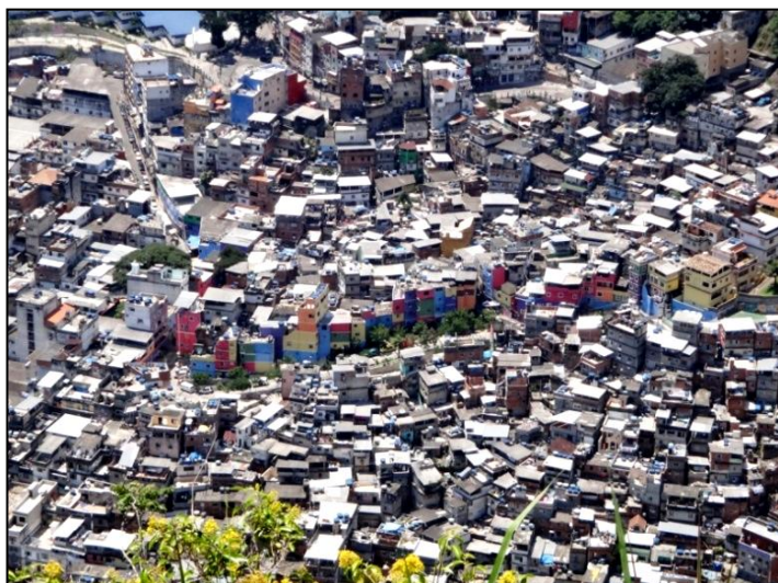
Photographie 24 : La densité du bâti à Rocinha
