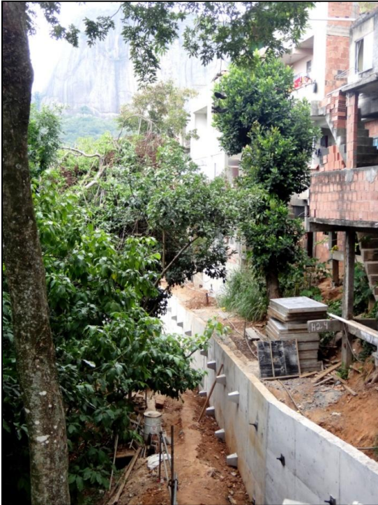
Photographie 69 : travaux de construction de murs de soutènement à Laboriaux à Rocinha
