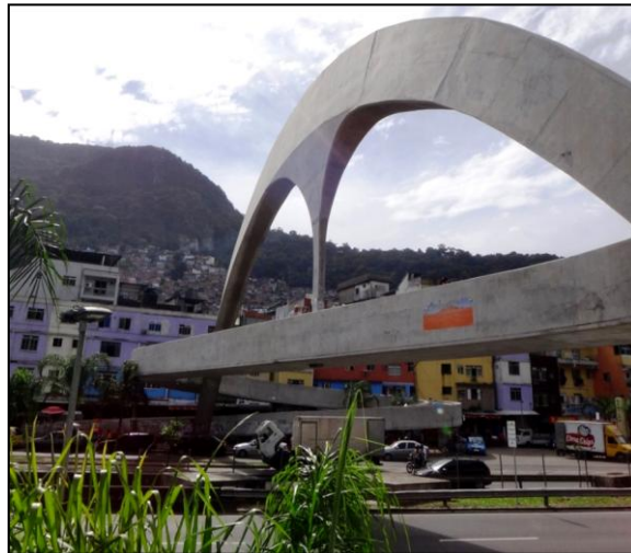
Photographie 66 : Passerelle Niemeyer traversant la route Lagoa-Barra et reliant le complexe sportif à la favela
