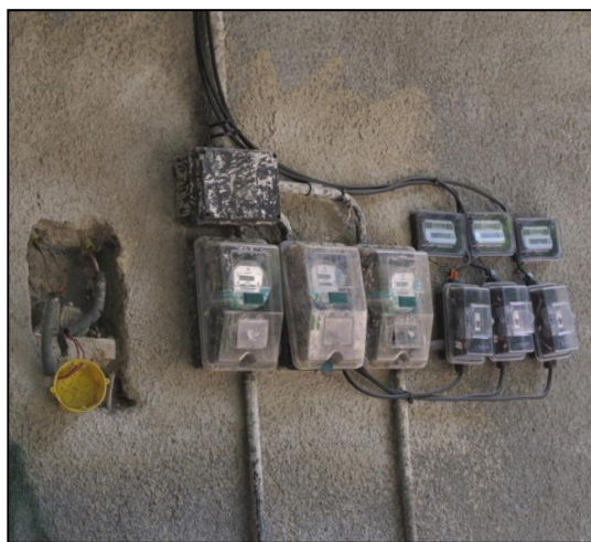
Photographies 26 : Exemples de compteurs et raccords électriques à Vidigal
