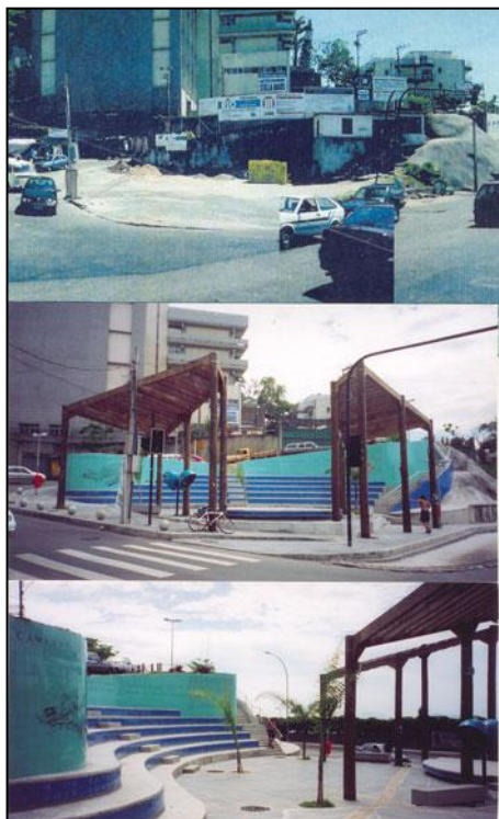
Photographie 16 : Construction de la place de Vidigal
