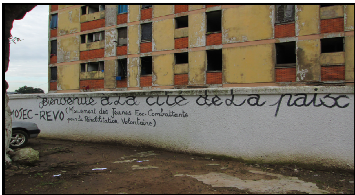
Figure 19: Façade et clôture d'un bâtiment de la cité Universitaire de Yamoussoukro.
