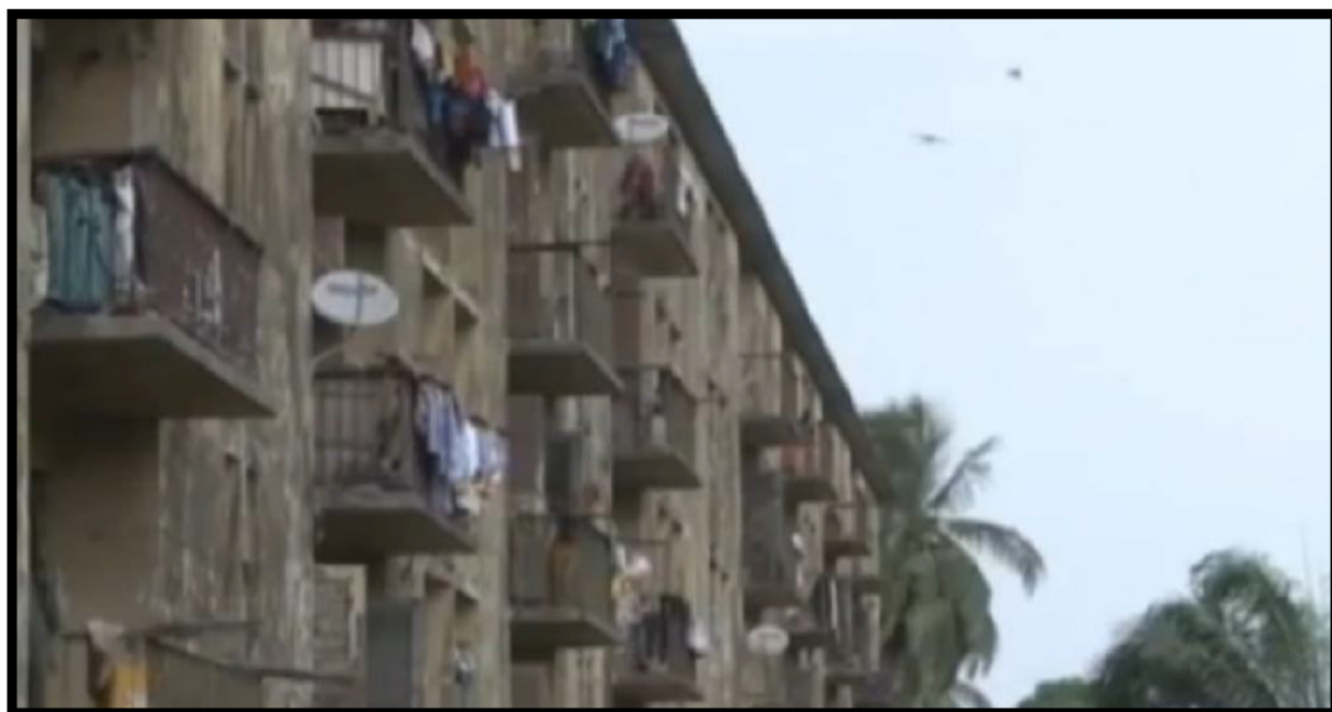
Figure 18:Façade d'un des bâtiments de la cité universitaire d'Abobo, 2014
