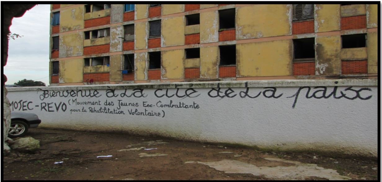
Annexe 6 : Façade et clôture d'un bâtiment de la cité Universitaire de Williamsville. Photo juin 2014 . Source : Enquête de terrain : photo de Binaté Amara
