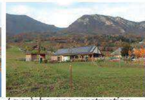
La crèche, une construction «isolée» implantée en limite de coupure verte avec un effort de traitement qualitatif de l'espace entre le bâtiment et la route : double alignement d'arbres, verger
