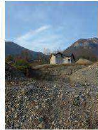
Construction récente et terrassements pour nouvelle construction : problématique d'implantation dans la pente
