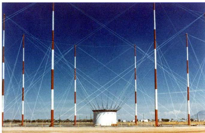
FIGURE 1.31 – Simulateur à dipôle vertical VPD-II de l'armée américaine [40]
