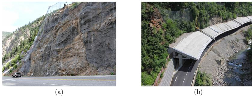
**FIGURE 1.5** – Illustrations de différentes protections passives permettant la déviation d'un bloc : (a) Filets déviateurs (source Trumer Schutzbauten), (b) Galerie de protection de la Combe Noire, Val d'Arly, France (source Leon Grosse)
