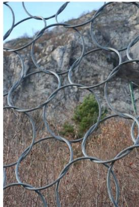
FIGURE 2.1 – Nappe à anneaux à 4 contacts (Coulibaly et al., 2017)
