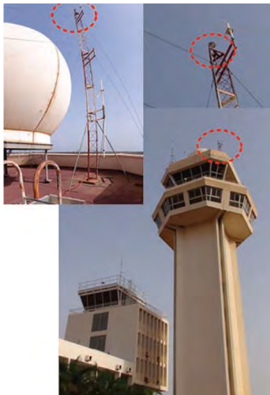
FIGURE 4.2 - POSITION D'UNE ANTENNE DE RÉCEPTION À OUAGADOUGOU (BURKINA FASO) [SECRETAN ET AL., 2014].
