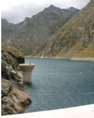
2 barrage de Soulcem
