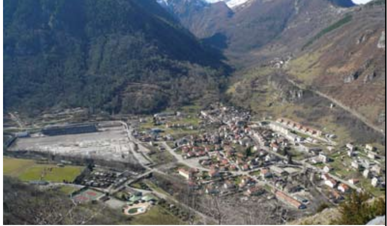
2 usine démantelée : une "encoche" dans le tissu urbain (Fév 2007)
