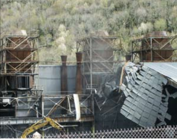
1 travaux de démolition de l'usine (Mars 2006)
