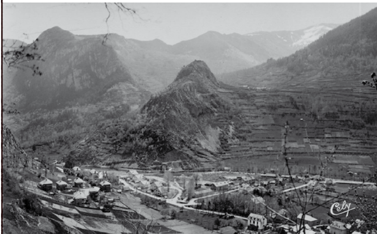
Extension du bâti, abandon de l'agriculture et enforestation sur les versants (S1)
