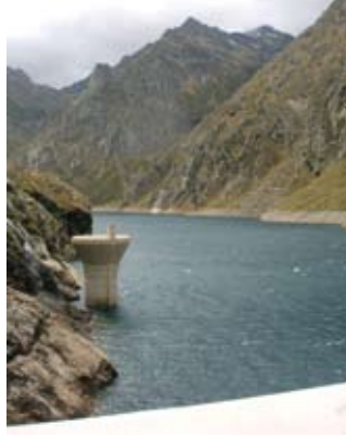
2 barrage de Soulcem
