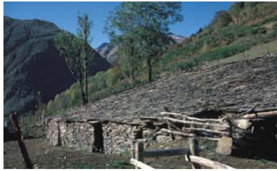
Abandon des granges de Moulinas (S3)
