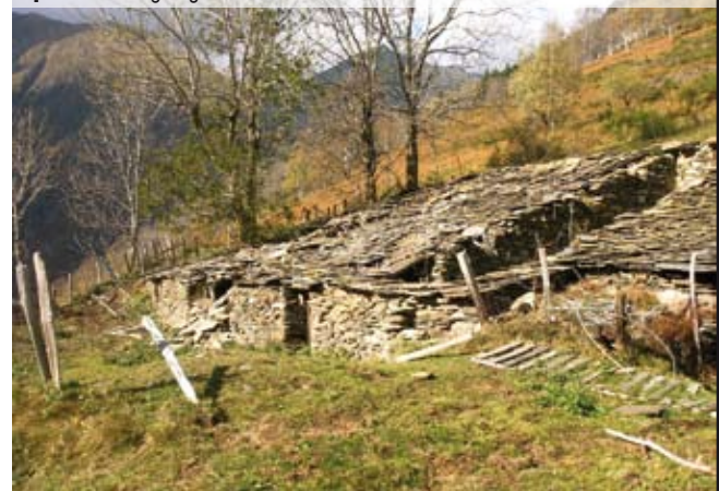
4 ruines des granges de Moulinas et enfrichement de la zone intermédiaire
