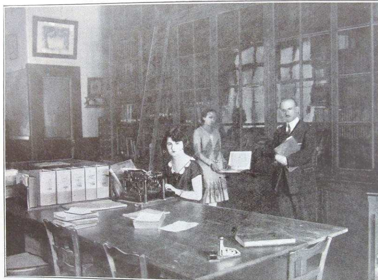
N° 2 — Salle de la Bibliothèque Technique (2 e cliché)
