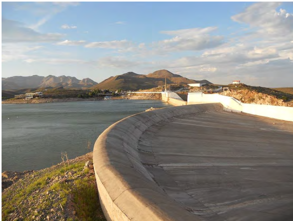
Photo 1 : Barrage la Boquilla, dit las Virgenes (Auteure, 2014)
