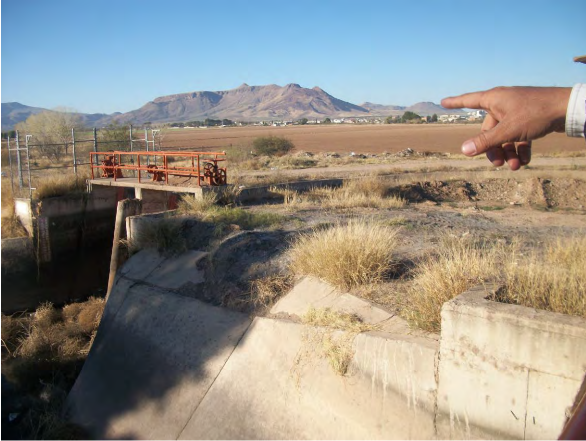
Photo 3 : Un canalero indique le système de vanne qu’il opère pour le Module 8 (Auteur, 2016)
