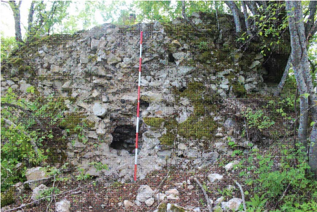
Fig. 189 : vue des vestiges de la tour de Pidiq-Gradina.
