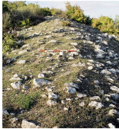
Fig. 751 : vue du rempart de Vërbovc.
