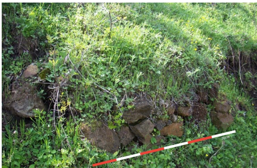
Fig. 149 : vue du parement externe de l'enceinte depuis le sud.
