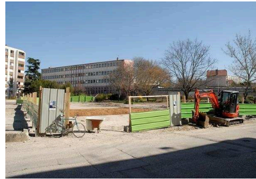
Pose des barrières de la pépinière 153
