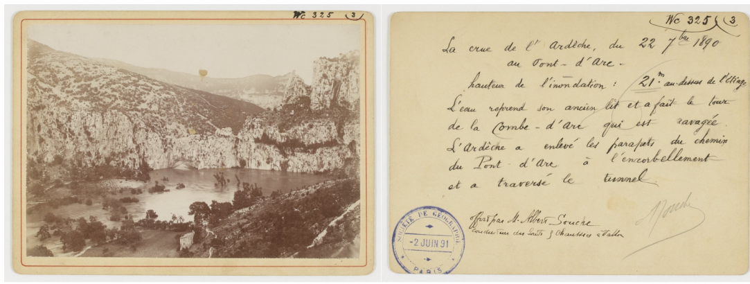
FIGURE 1.12 – Photo de la crue de l'Ardèche du 22 septembre 1890 au Pont-d'Arc, don Albert Souche en 1891. Source : https://gallica.bnf.fr/ark:/12148/btv1b85538575/f5.double
