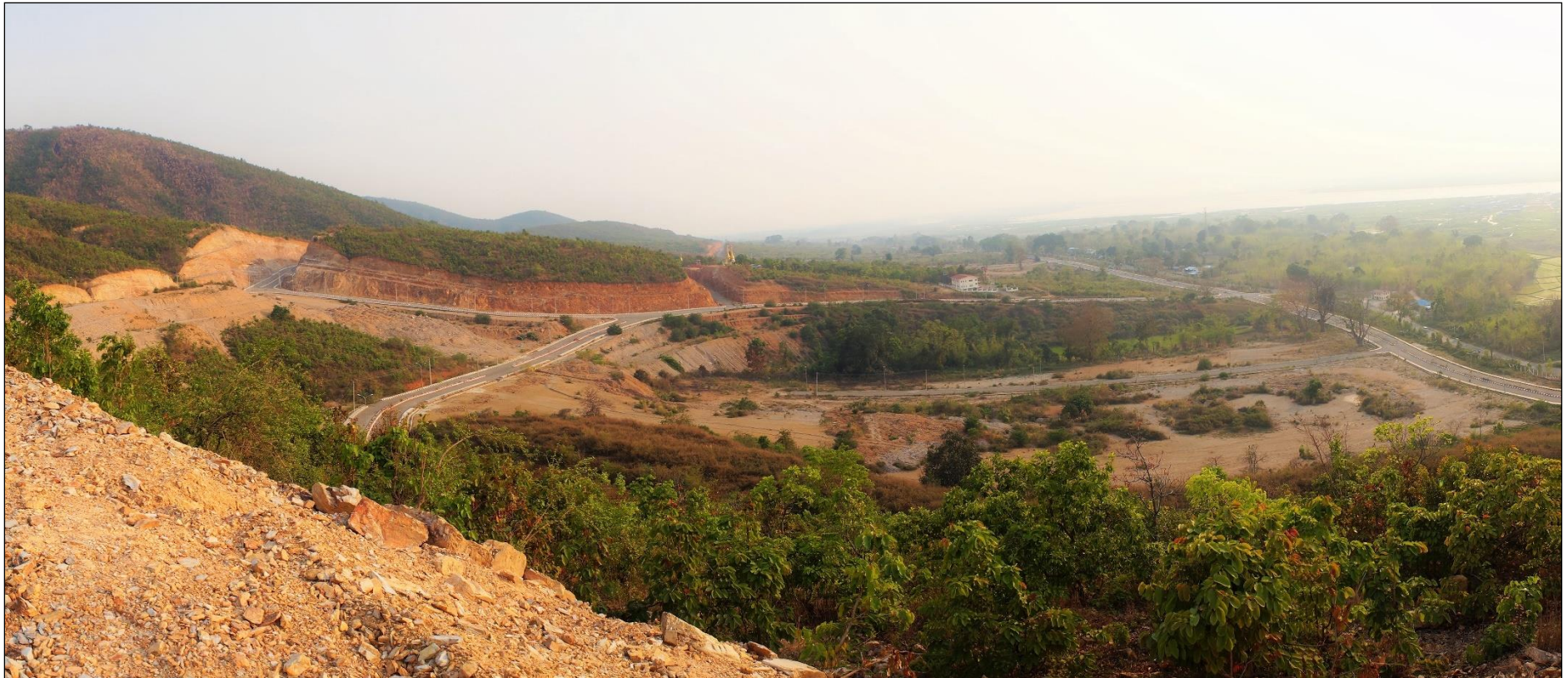
Figure 56 : La zone hôtelière à l'abandon, vue selon un axe nord-sud. Noter l'importance des travaux de terrassement et la largeur des axes routiers. Cliché : Martin Michalon, avril 2016
