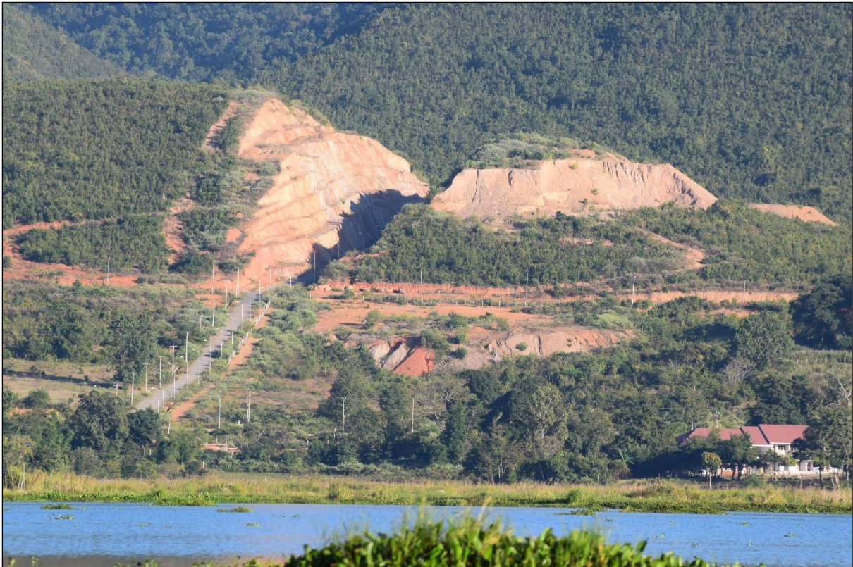
Figure 54 : Phyu Zin dans la zone hôtelière : des travaux colossaux qui bouleversent le paysage. Les lampadaires sur la route donnent une idée de l'ampleur du terrassement. Cliché : Martin Michalon, décembre 2016
