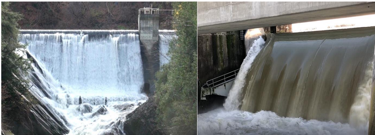
Figure 1 - Exemples d'écoulements aérés : déversement des barrages de Coaticook (à gauche, photographie de Dr. Matthieu Dufresne) et de Gambsheim (à droite, photographie de Prof. José Vazquez)
