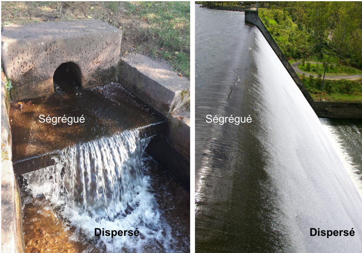
Figure 16 – Chute d'eau en sortie de collecteur générant l'aération localisée (à gauche, photographie de Dr. Sandra Isel) ; évacuateur de crue présentant le phénomène d'auto-aération (à droite, Source : Freemages)
